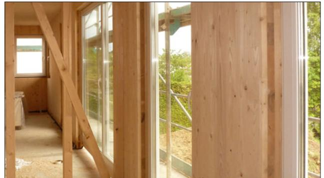
Fertighaus: vorgefertigte Wandelemente aus „Brettsperrholz“, 90 mm stark
