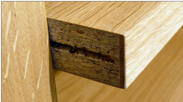
Regalboden: eichefurnierte Spanplatte mit Umleimer an der Vorderkante
