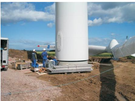
Hier wird das erste von 3 Rohren des Turmes auf das Fundament gesetzt.
